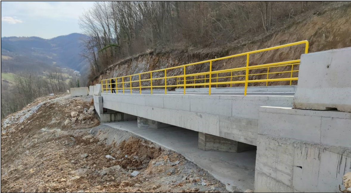
Слика 3. - Изведени радови на санацији клизишта на делу пута између Сушице и нове цркве
